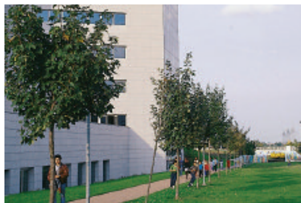
Réalisation de chemins piétonniers facilitant l'accès aux immeubles.
